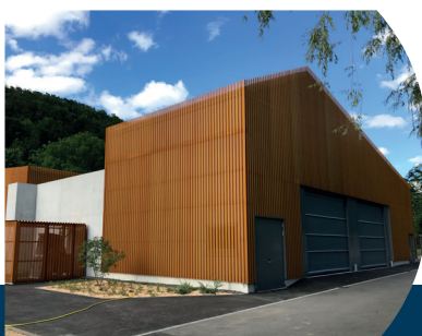
Station d'épuration de Delémont (Suisse) - 39 000 E.H. Traitement des micropolluants (CarboPlus® eaux usées)
