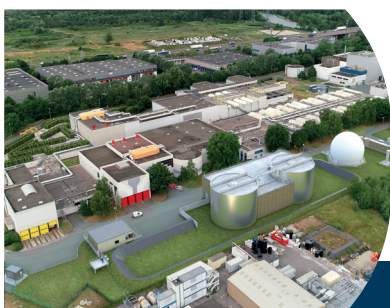
Station d'épuration de Saint-Thibault-des-Vignes (77) - 350 000 E.H. Valorisation énergétique des boues et injection de biogaz
