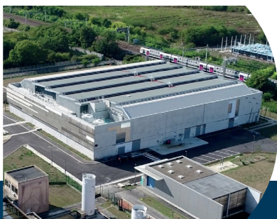
Usine de production d'eau potable d'Orly 2 (94) - 150 000 m 3 /j Traitement de la matière organique (Delreb®), et des micropolluants (CarboPlus® eau potable)
