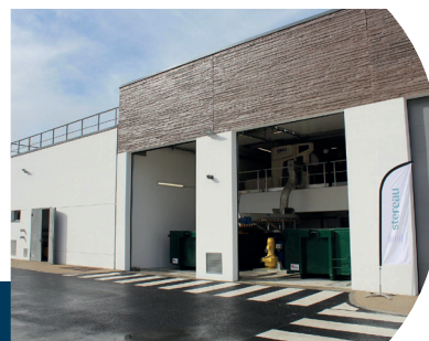
Usine de production d'eau potable de Coulommiers (77) Traitement du fluor et du strontium
