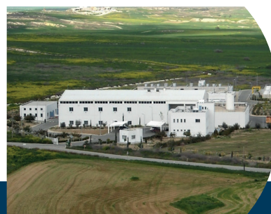
Station d'épuration de Vathia-Gonia (Chypre) - 200 000 E.H. Réutilisation des eaux usées traitées (traitement membranaire Aqua-RM®)
