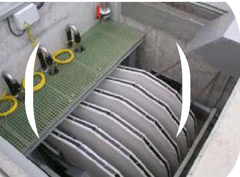
Stereau a sélectionné ce procédé de filtration gravitaire pour sa **performance**, sa **compacité**, sa **robustesse**, sa **simplicité** de fonctionnement, mais aussi pour son **faible coût d'exploitation** tant en énergie qu'en maintenance - caractéristiques qui le rendent particulièrement bien adapté à la filtration tertiaire des eaux usées et qui s'inscrivent dans la démarche développement durable de Stereau.
