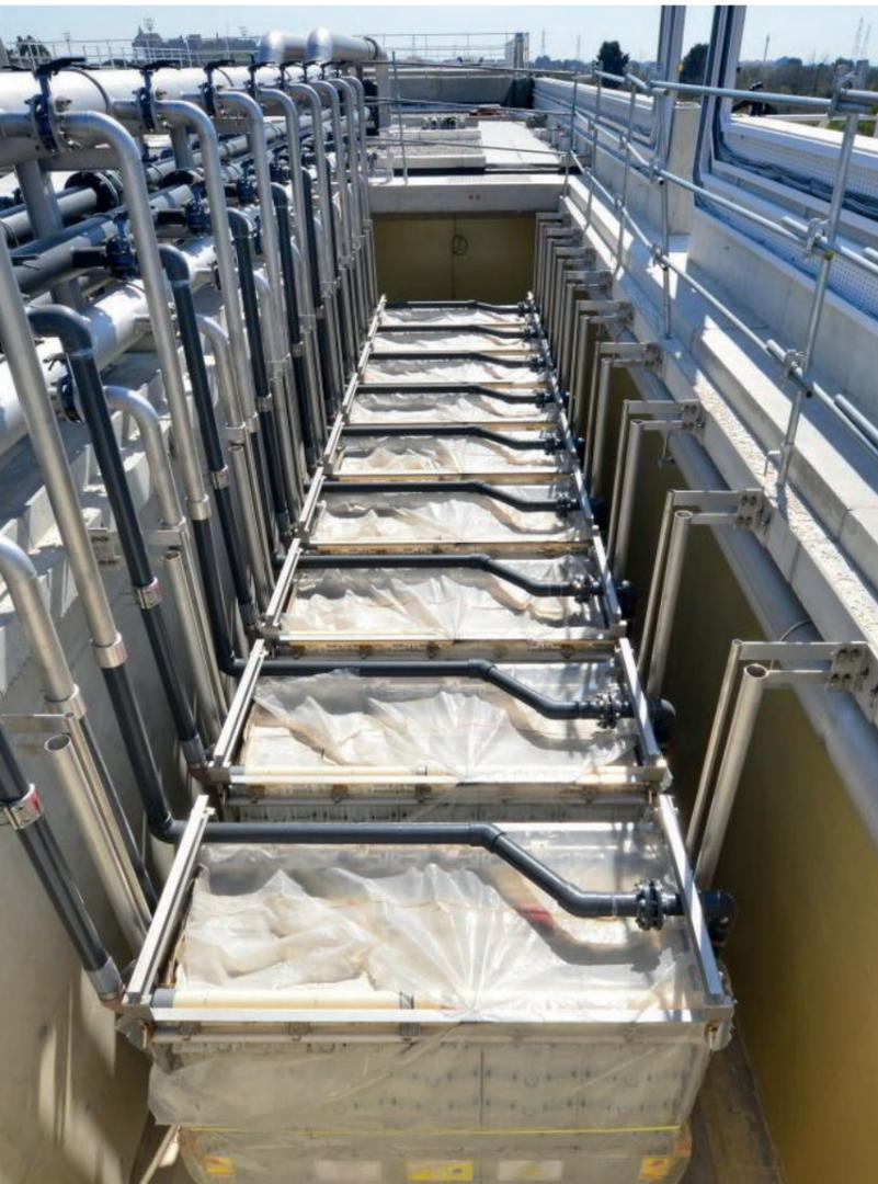
Le traitement des eaux usées par un bioréacteur à membranes plaques Aqua-RM® permet le rejet d'une eau de haute qualité.
