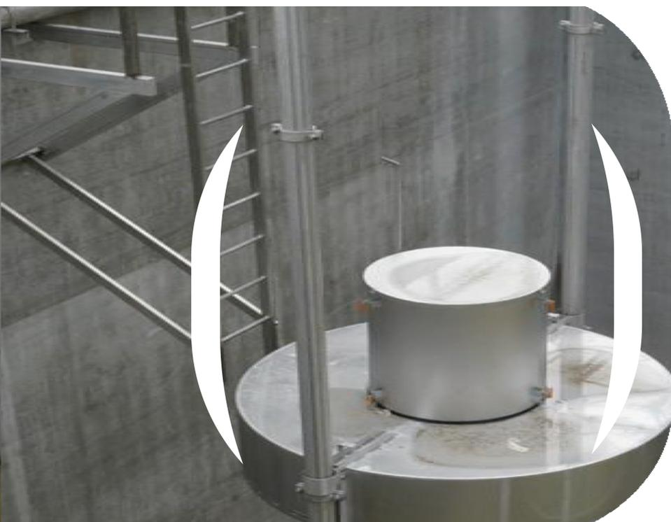
Alternative au procédé conventionnel par boues activées, le traitement biologique et la décantation de la boue sont réalisés non pas en continu dans des ouvrages distincts et successifs mais au contraire alternativement dans le même ouvrage. Ce procédé cyclique met donc en œuvre 2 à 4 bassins de traitement, avec ou sans bassin tampon selon les versions.
